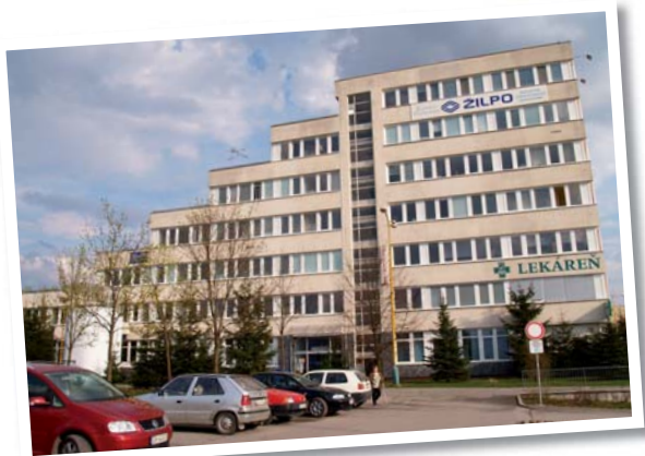
Budova ambulatného zdravotníckeho zariadenia ŽILPO, s.r.o. v Žiline
