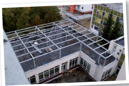
Oceľová konštrukcia nadstavby prvého poschodia nad detským oddelením hradená z prostriedkov OPZ. Nadstavbou sa získali priestory pre 2 ambulancie praktických lekárov a 2 odborné ambulancie.
