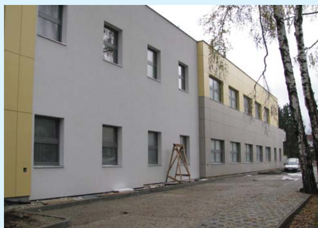
Dokončovacie práce na fasáde budovy urgentného príjmu FNsP v Žiline
