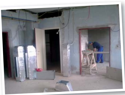
Rekonštrukčné práce v bronchologickej sále.
